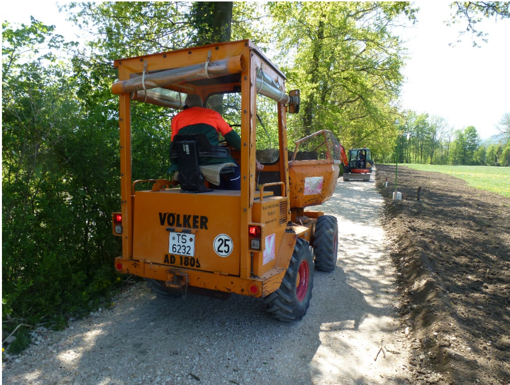
Abb. 1: Flussmeisterstelle Piding: Vorbereitungsarbeiten für den Wegstreckeneinbau
